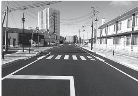
県道竣工の様子（東側）
