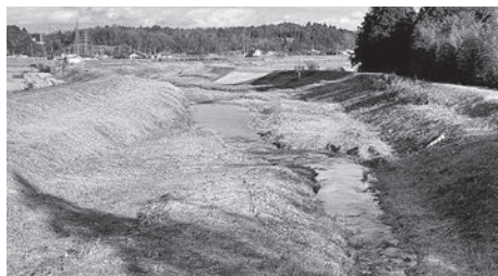
災害対策等工事が進む太田川
