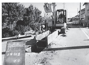
下水道工事の様子
