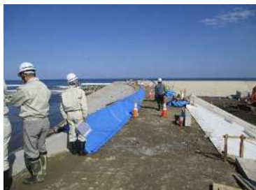
現地調査状況
