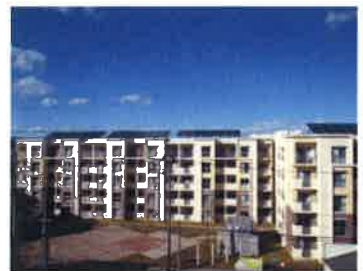
災害公営住宅（大町東）
