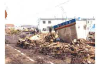
瓦礫の山 (原町区)
