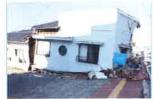
建物の全半壊が多く見られた (小高区)
