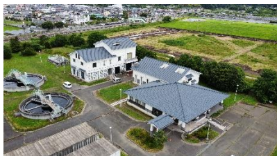
【小高浄化センター】
