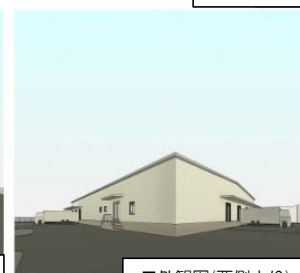
■外観図（西側より）
