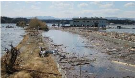
津波被災した排水機場と湛水した農地
