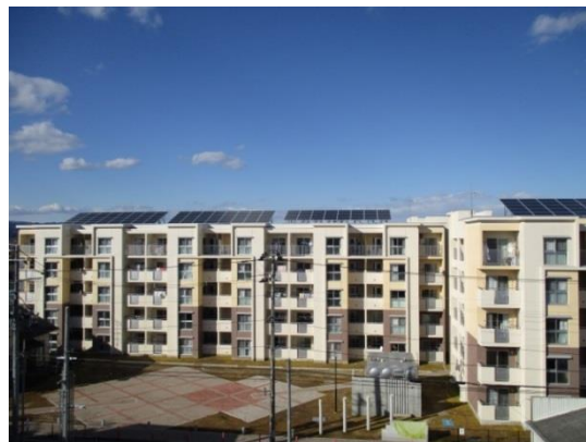
災害公営住宅（大町東）
