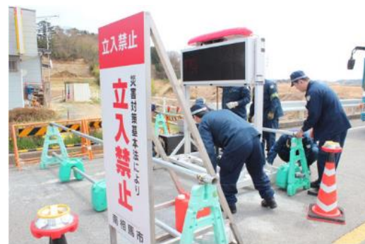
〔案内板の撤去（H24.4.16）〕
