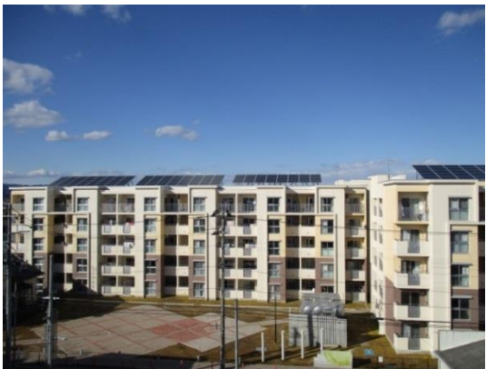
災害公営住宅（大町東）
