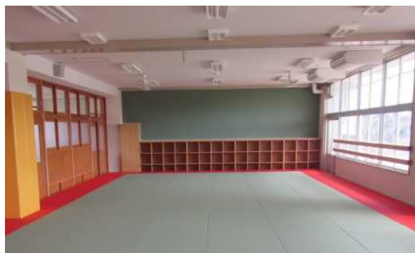
小高中学校 柔道場改修状況
