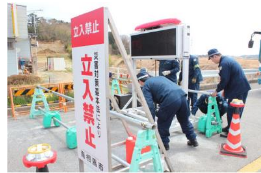
〔案内板の撤去（H24.4.16）〕
