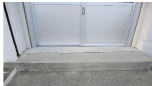
①地震により基礎部分に亀裂が生じた校舎
