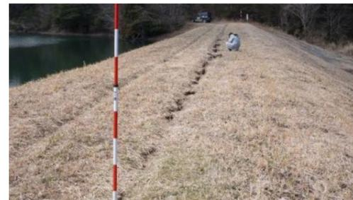
②地震により堤体に亀裂を生じた勘判ため池 (鹿島区北屋形)
