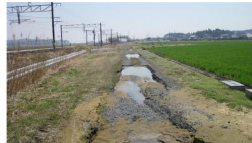
⑥地震により破損した高パイプラインと農道 (原町区高)
