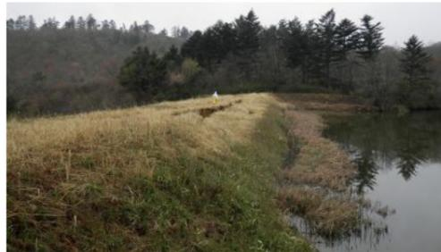
⑦地震により前法が崩落した太良谷地ため池 (小高区羽倉)
