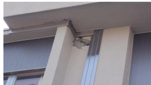
④地震により外壁が剥離した校舎
