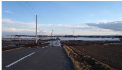
①地震により陥没し津波を受けて冠水した市道
