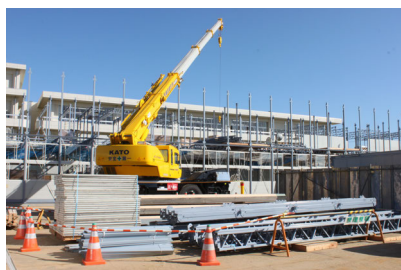
写真-2 仮設校舎の建設（鹿島小）
