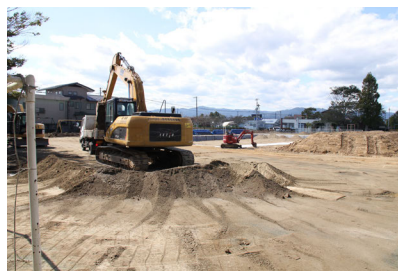
写真-4 表土剥ぎ取り作業（高平小）
