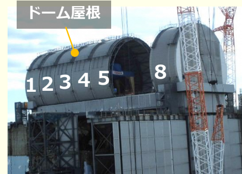
燃料取り出し用カバーの設置状況 （撮影日2017年12月19日）
