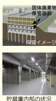
貯蔵庫内部の状況
