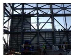
前室部南面の外装パネル設置状況 (撮影2023.11.28)
