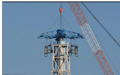
【写真②】斜材切断状況(11月6日)
