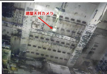
作業前 (撮影日:2024年11月22日)
