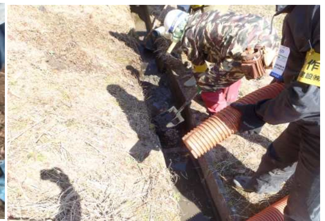
吸引車による汚泥除去
