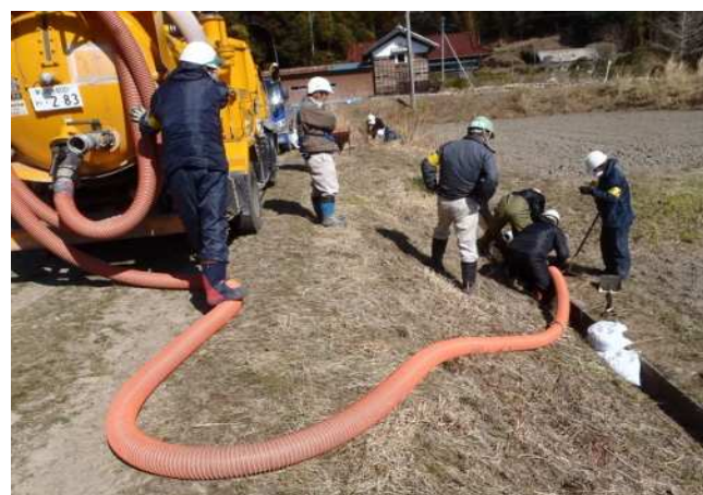
吸引車による汚泥除去
