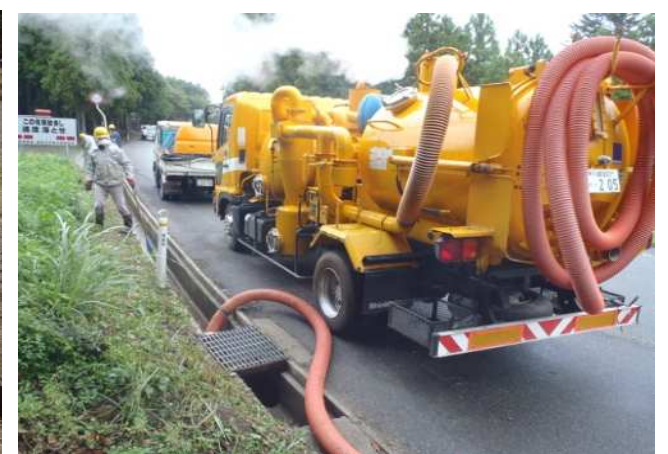
吸引車による汚泥除去
