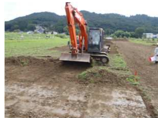
バックホーによる表土削取り例
