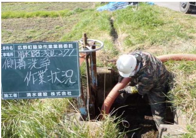
吸引車による汚泥除去
