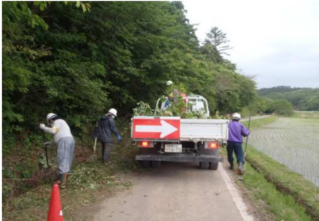
路肩・法面の除草作業
