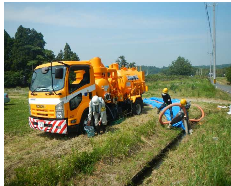
原町区片倉地内の水路除染風景
