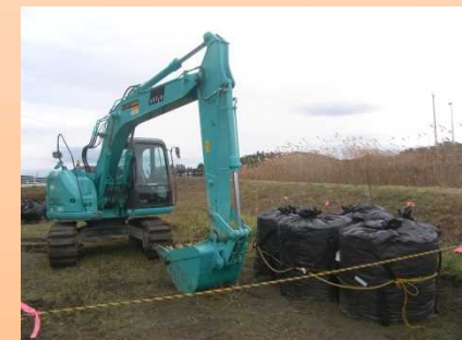
土のう袋の固定
