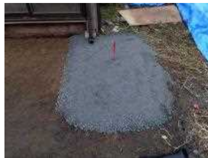
施工後の様子
