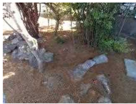
施工後の様子
