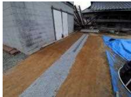
施工後の様子
