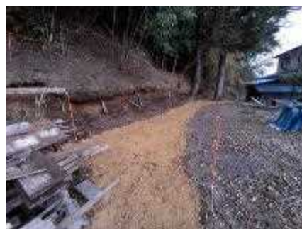
施工後の様子
