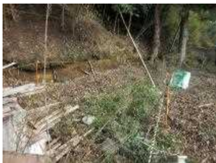
施工前の様子
