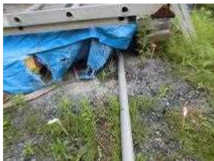
施工前の様子
