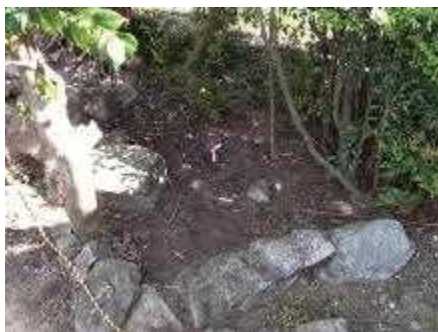
施工前の様子
