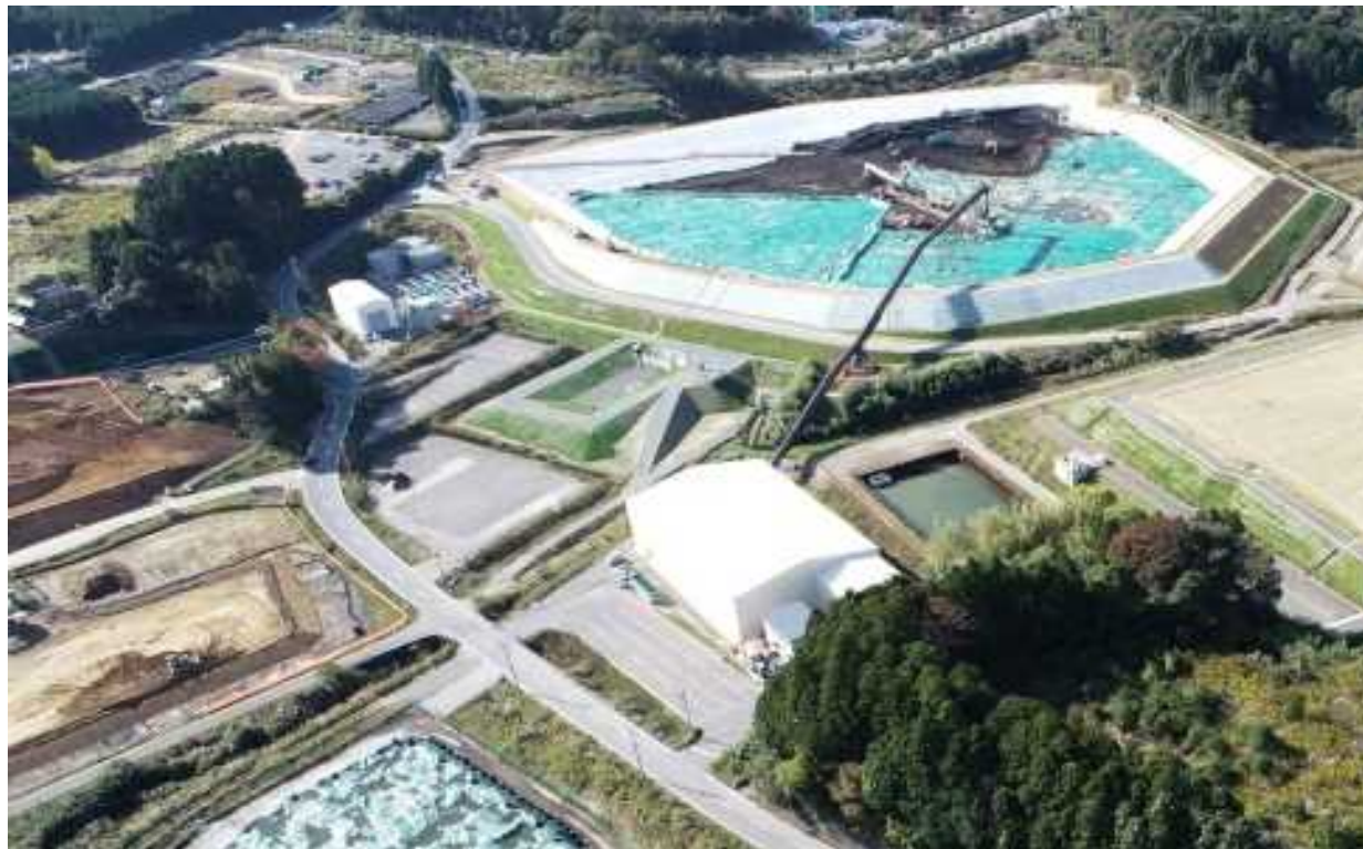
土壌貯蔵施設（西側）
