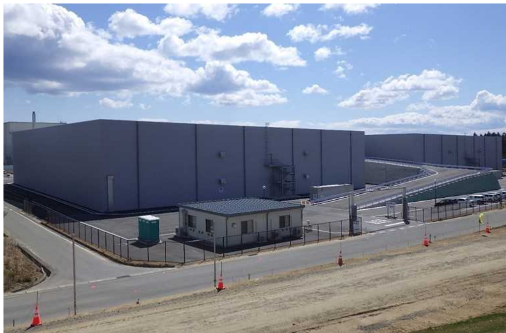
廃棄物貯蔵施設の外観
