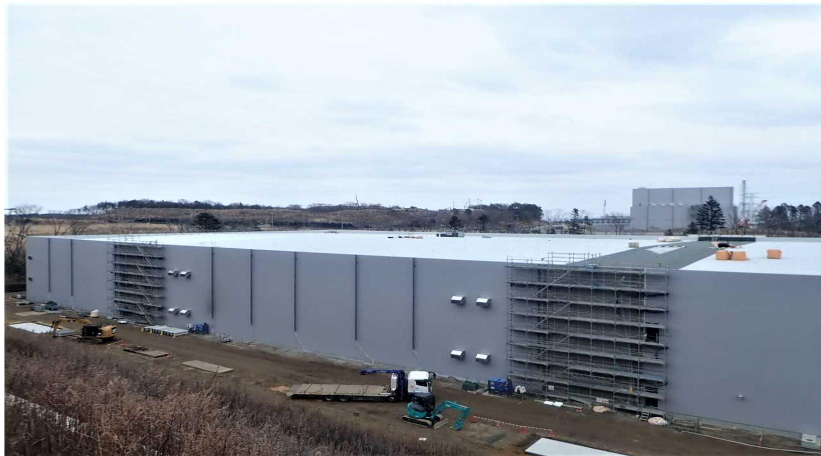
西側法面上部より全景写真
