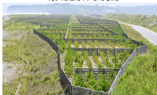
小高区に整備された海岸防災林
