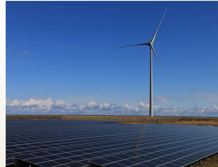
万葉の里風力発電所（写真提供：（株）南相馬サステナジー）
