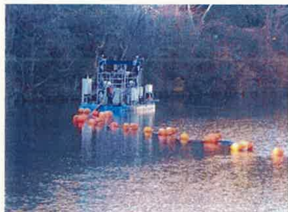
浚渫作業状況
