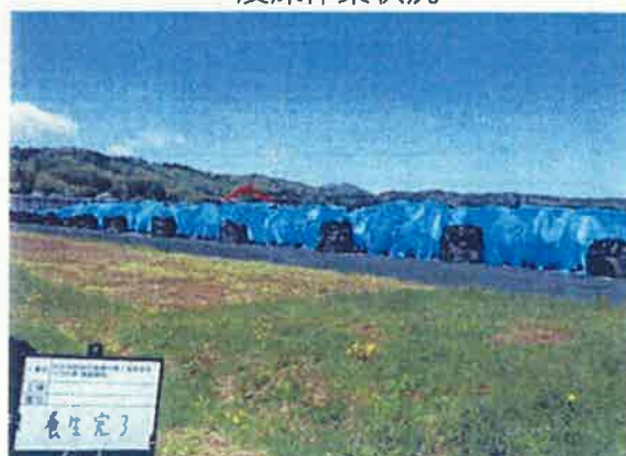
フレコン搬出完了後（信田沢仮置場）
